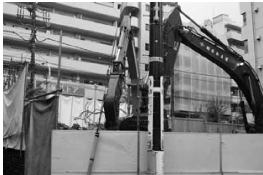
解体された恵比寿参番館
